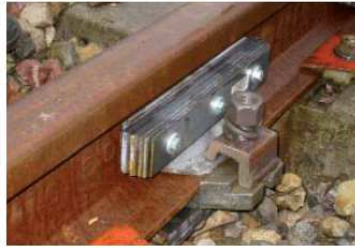
Exemples d'absorbeurs sur rail (Corus et Socitec)
