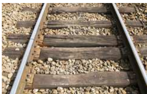
Rails courts sur traverses bois
