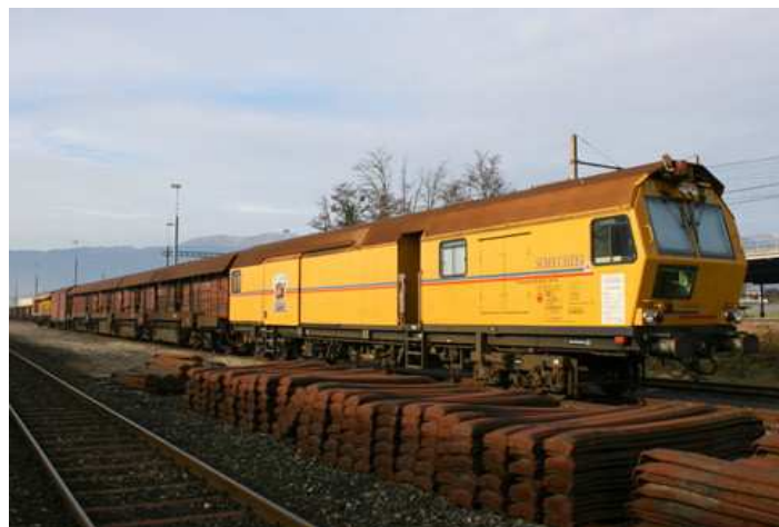
Train meuleur de rails (Scheuchzer S.A.)
