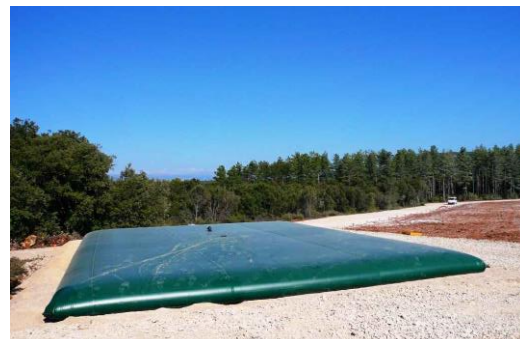
Figure 8 : Photographie d'une citerne
