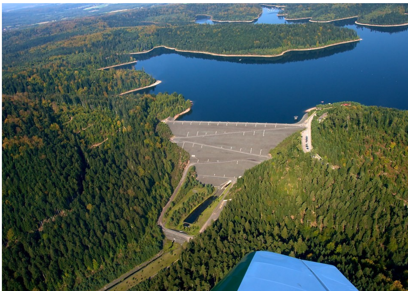
Barrage de Pierre-Percée
