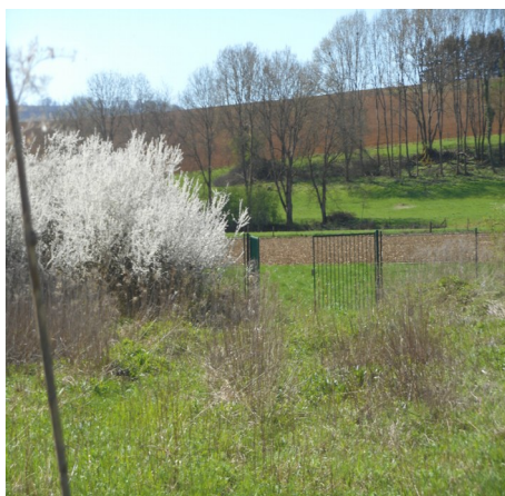
Périmètre de protection d'un captage envahi par la végétation et portail non verrouillé
